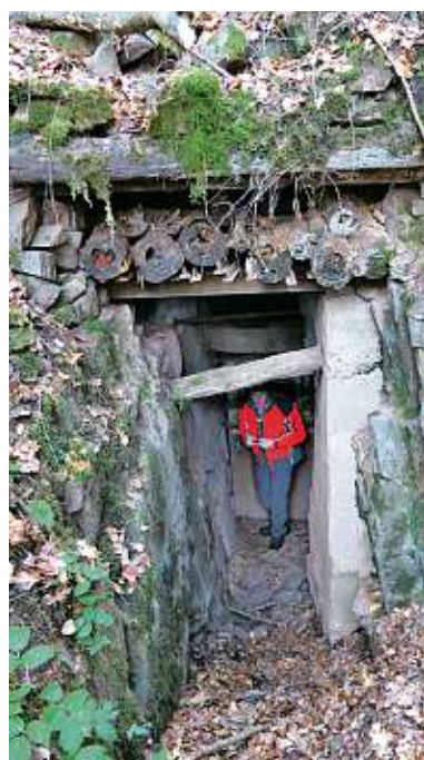
Beim Eisenrissweg: Den alten, versteckten Erzstollen nutzen Fledermäuse.
