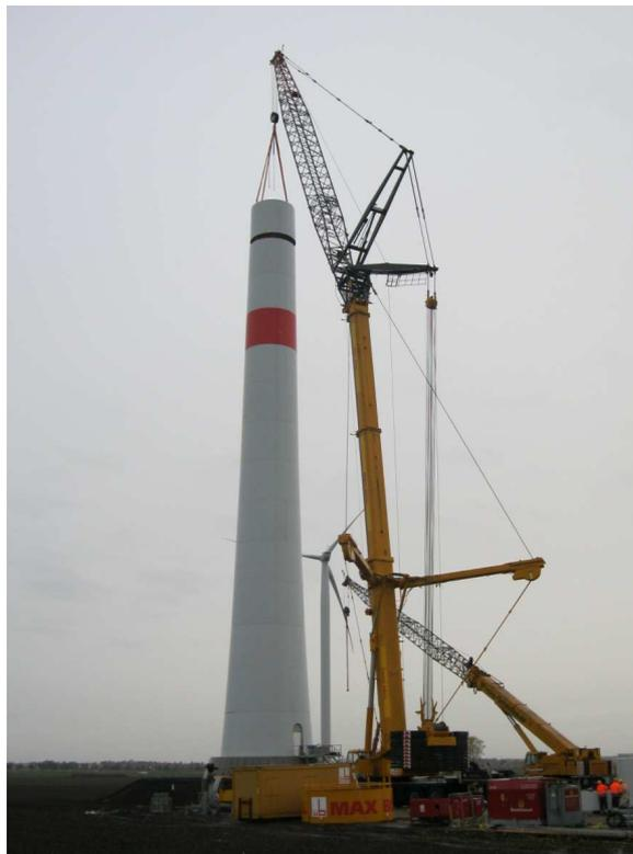
**Abbildung 2: Montage eines Turmrings / assembly tower ring**
