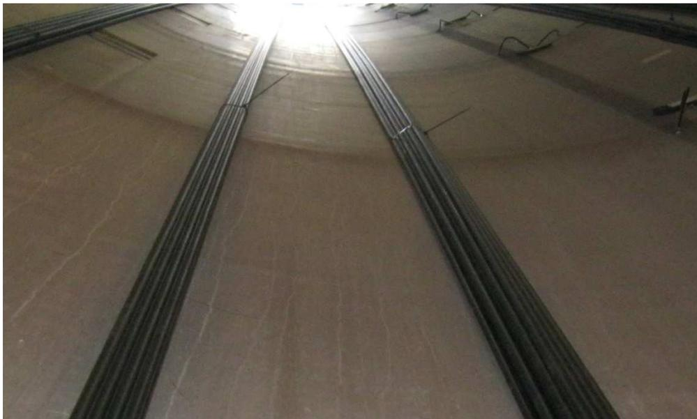
Abbildung 3: Eingebaute Spannglieder/ pretensioned tendons
