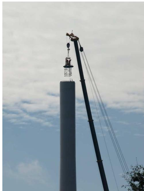
**Abbildung 7:** Einhebevorgang Adapterplattform mit dem Gitterelement / Hoisting process of transition piece platform with grid element
